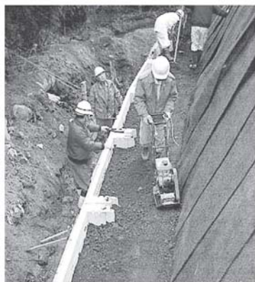
5 下層部-胴込材・裏込材の一括充填・転圧
