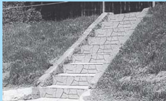
栃木県 田沼町役場 栃本大沢池水辺景観整備工事
