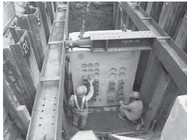
特殊部I型(通信・電力)施工写真
