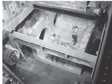
特殊マンホール(推進立坑)施工写真
